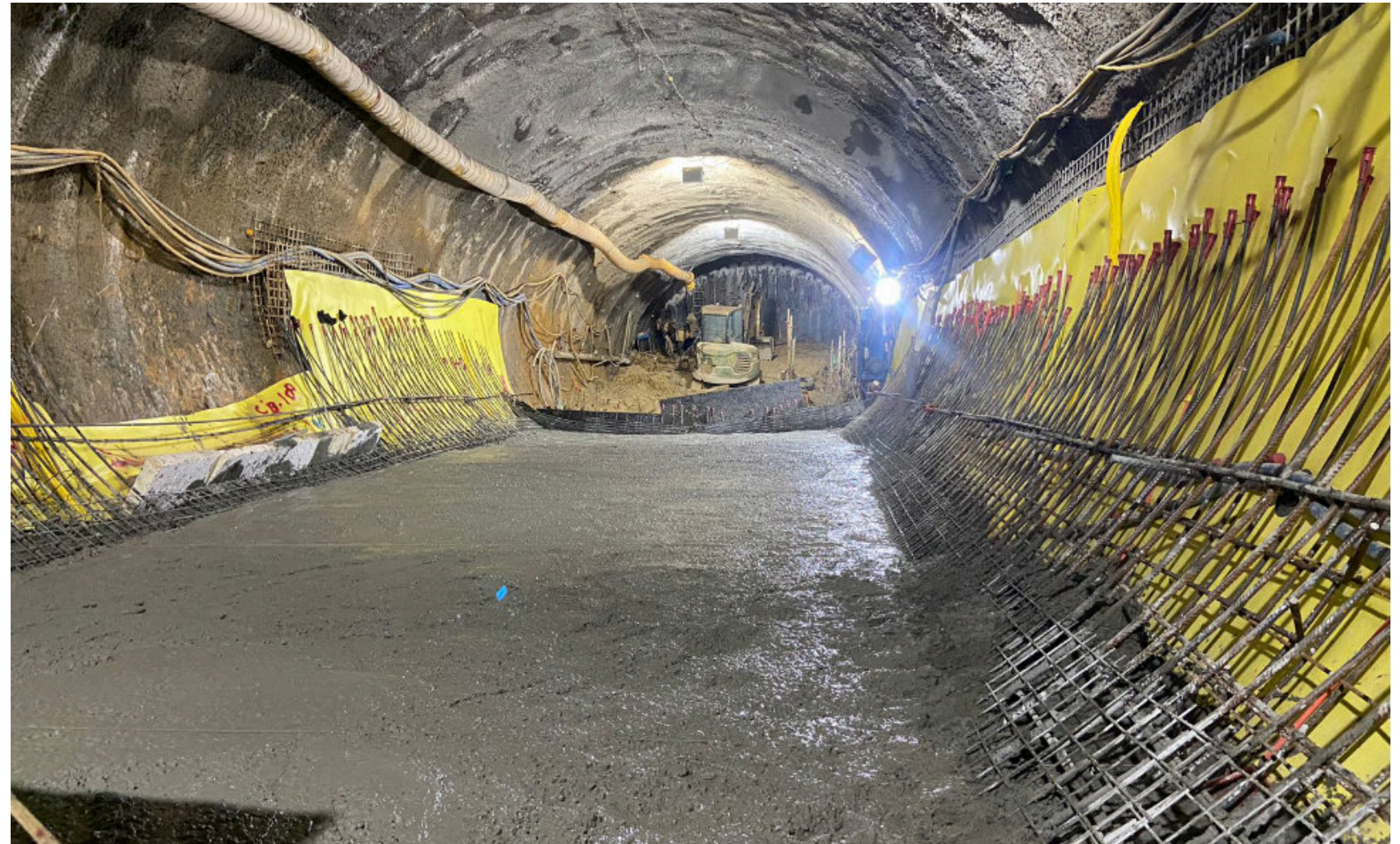
Foto: Revestimento secundário do Túnel Norte
