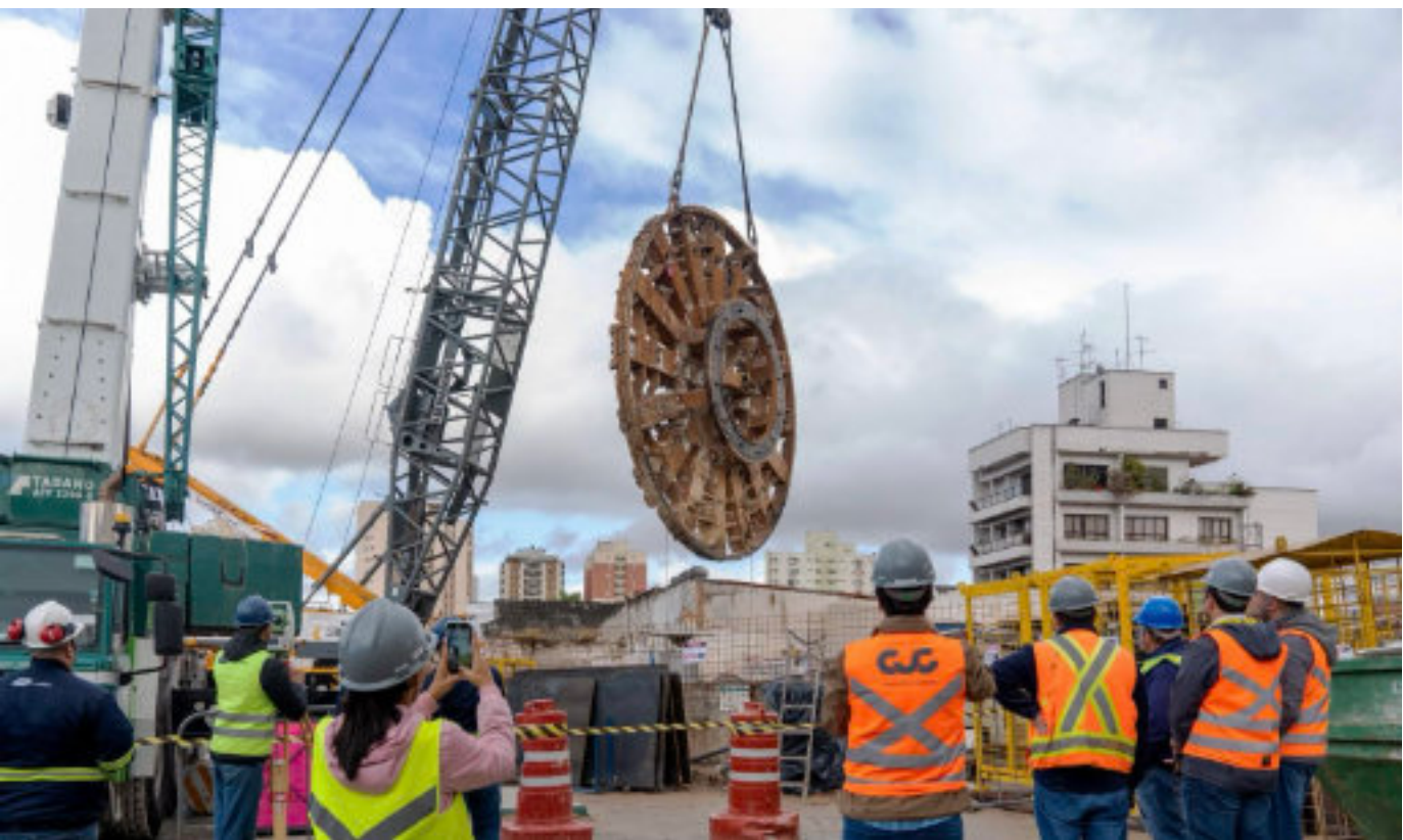
Foto: Vista da desmobilização da Tuneladora
